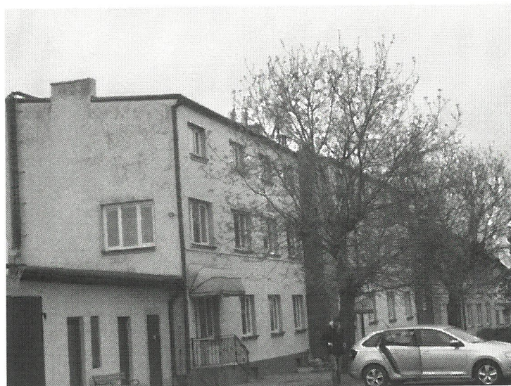
Zal. nr 1: Widok ogólny instalacji radiokomunikacyjnej.
