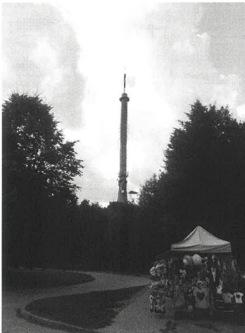
Zdjęcie 1 Badany obiekt
